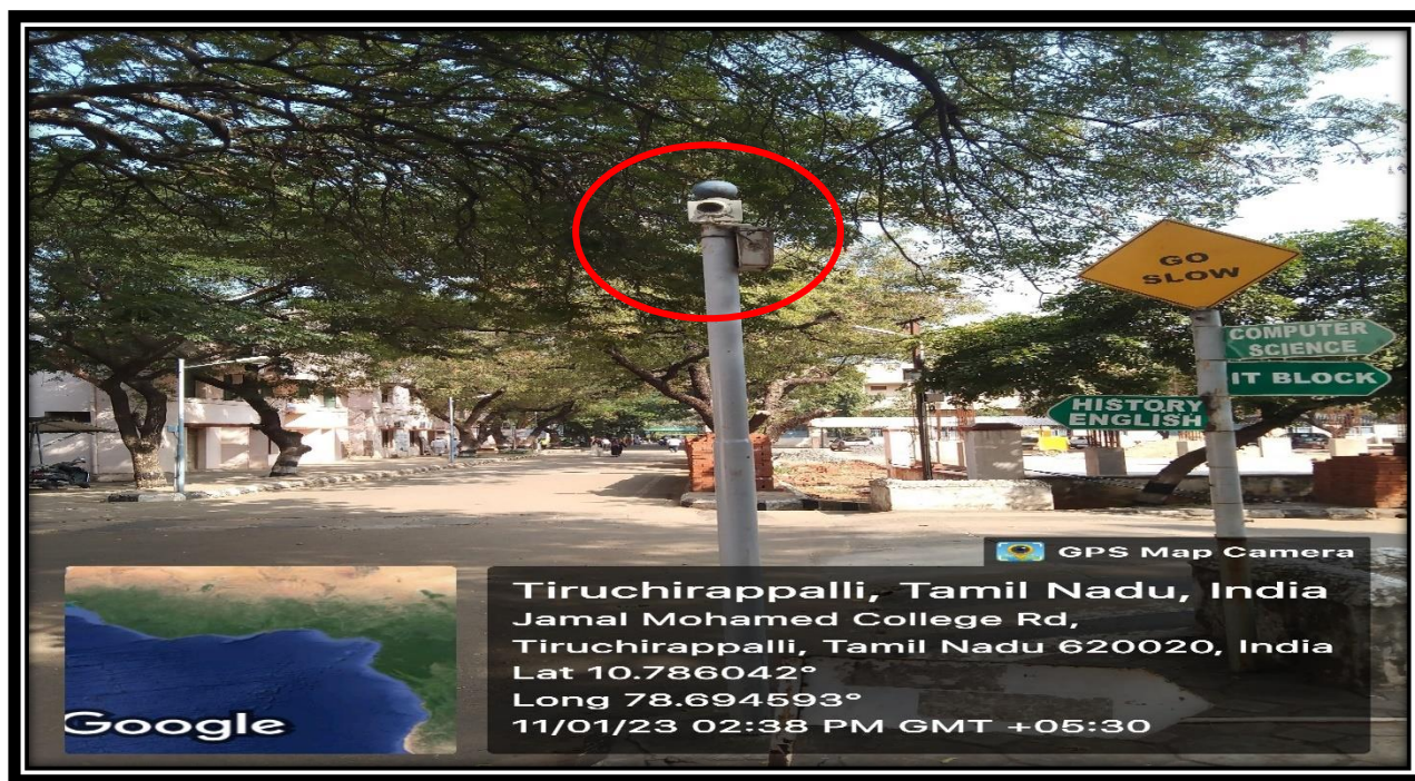
CS-BLOCK -SURVEILLANCE CAMERA
